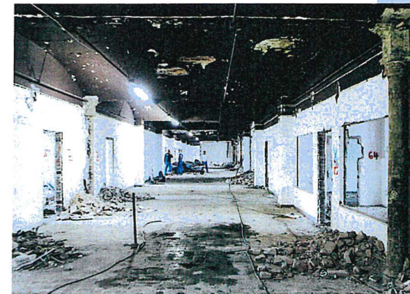
Schutthalde: Um die historische Substanz zu schonen, wurde der Großteil der 20.000 Tonnen Bauschutt in Handarbeit beräumt
