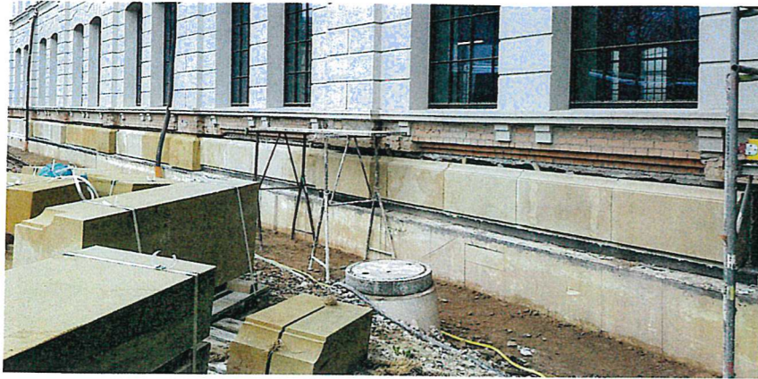
Statt des einst verbauten Cottaer besteht der Sockel nun aus Postaer Sandstein, weil dieser härter sowie absolut frost- und witterungsbeständig ist – und sich deswegen für die eine Verwendung als Außensockel besser eignet
