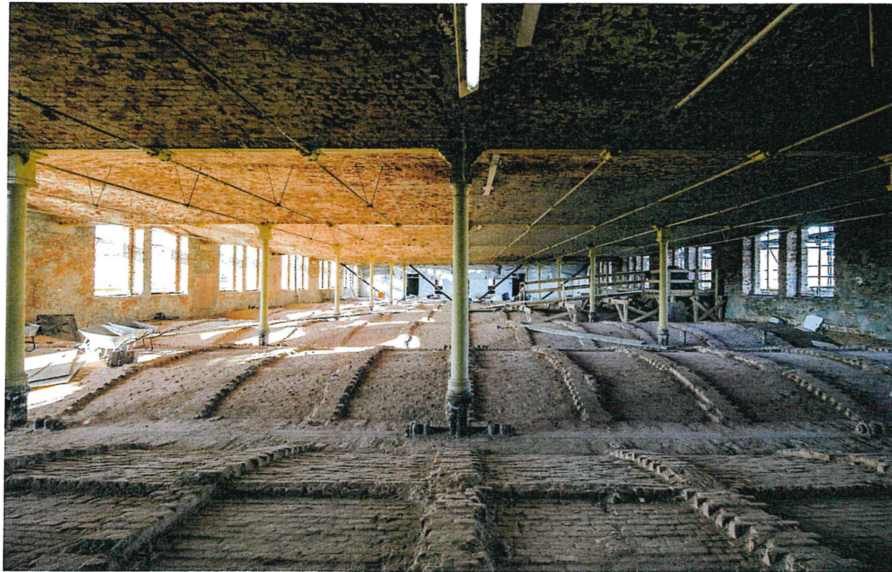
Denkmalgeschützte, eindrucksvolle Tragkonstruktion aus Gusseisenstützen, Spanngliedern und Gewölbekappen, die ...
