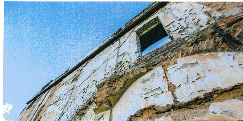
Viel blanke Haut: Die Gewände und Bänke aller Bogenfenster der ehemaligen Aktienspinnerei und neuen Zentralbibliothek der Technischen Universität Chemnitz wurden aus Cottaer Sandstein neu gefertigt
